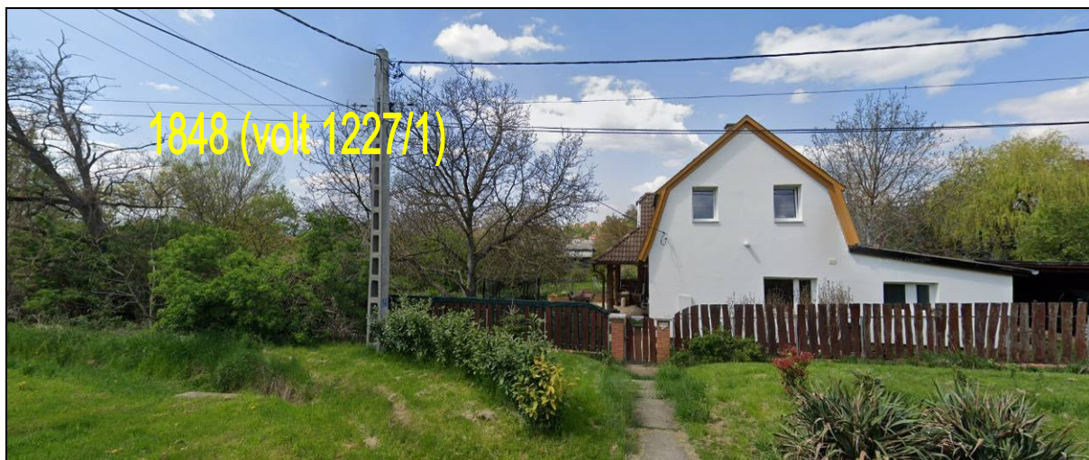
A 1848 hrsz (volt 1227/1 hrsz) módosítással érintett terület keleti felén álló meglévő épület
